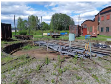
Vändskivan rotskyddsmålas och får nytt plankdäck.
