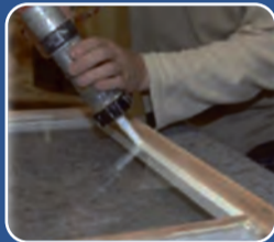
Energiglas monteras och kittas
