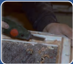
Kitt och glas avlägsnas. Bågen rensas, slipas ren och fuktkontrolleras
